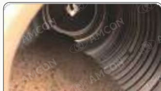
2 Inside of the Dryer 干燥機內部
